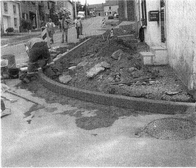
Elargissement du trottoir de la Grand'Rue
